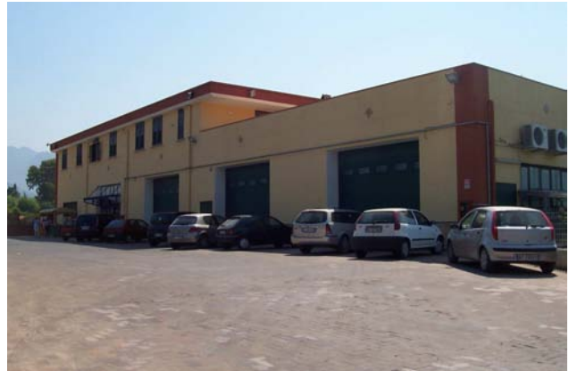
Piazzale ingresso al supermercato
