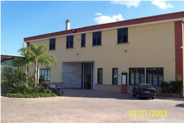
Piazzale d'ingresso alla palazzina
