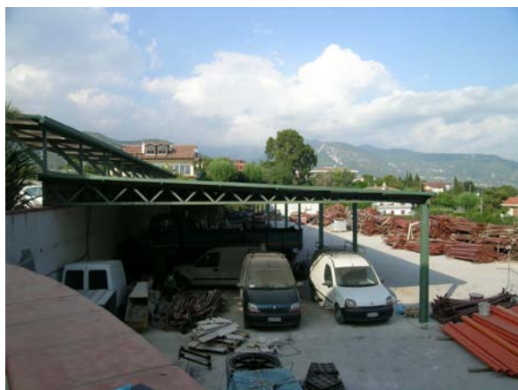
Vista dell'area esterna comprensiva di tettoia
