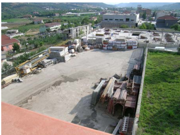
Vista della rampa di accesso e del piazzale laterale
