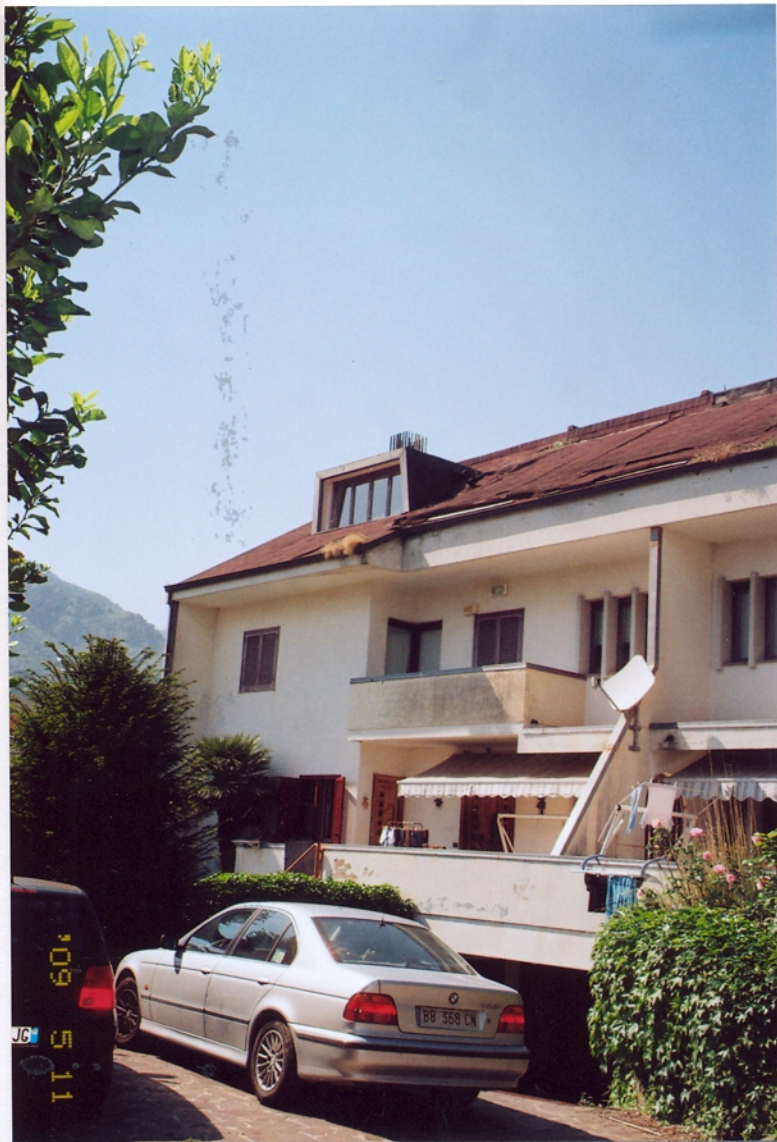
FOTO 5 FRONTE SUD DEL VILLO NO OCCIDENTALE.
