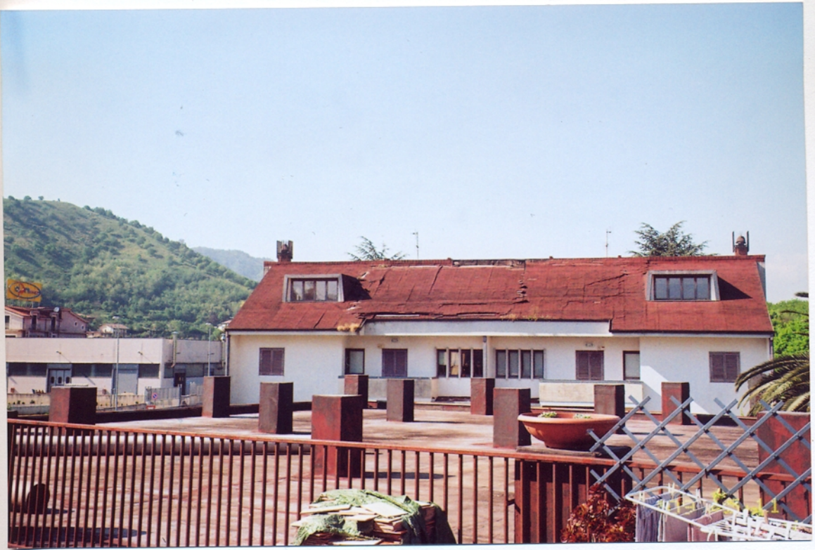
FOTO 4 VEDUTA DA SUD DEL CORPO B)
