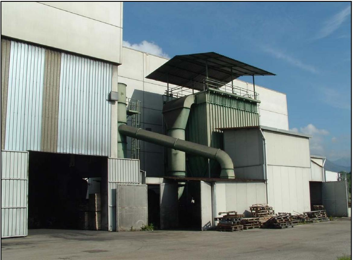
**FOTO N.º: 16 –Retro Capannone Produzione –Zona Torre rigenerazione posizionata zona pensilina chiusa con pannelli metallici-**
