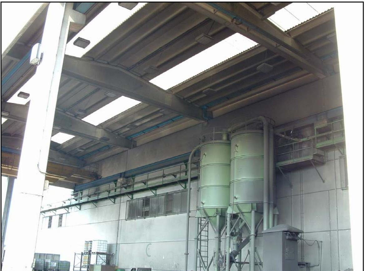
**FOTO N.º: 24 –Interno Pensilina silos da 24 mc per sabbia nuova-**
