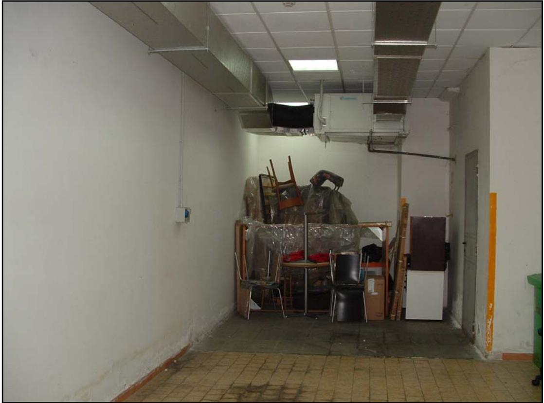
**FOTO N° 5: Piano Terra Box Auto-rispetto al progetto in atti al SUAP è stata eliminato un tramezzo (fra attacco diverse pavimentazioni)**
