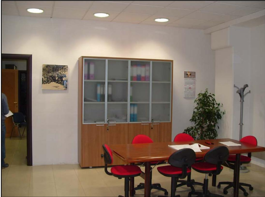
**FOTO N° 9:** La originaria sala riunioni costituita da un unico grande ambiente è stata frazionata in due ambienti più piccoli con la realizzazione di una parete in cartongesso
