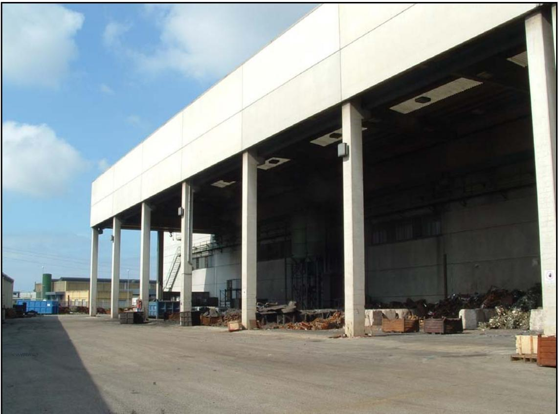
**FOTO N.º: 22 –Retro Capannone- Pensilina stoccaggio materiale per fusione dotata di carro ponte con elettrocalamita**
