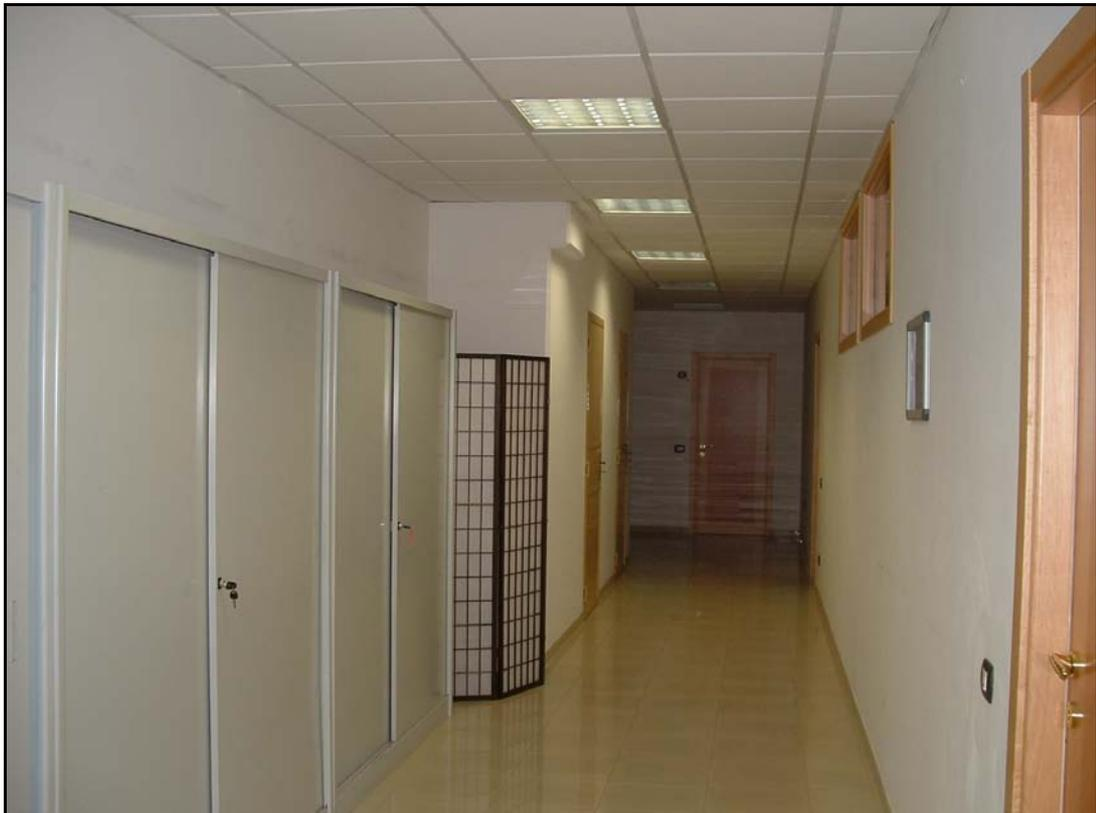
**FOTO N° 8: Corridoio di disimpegno Piano Secondo- Nella parte terminale il corridoio si restringe stante la creazione di un cavedio impianto (difforme dal progetto in atti al SUAP).**
