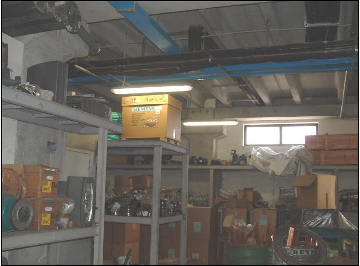
**FOTO N° 3: Piano Terra Magazzino –si nota struttura a vista del tipo prefabbricata con solaio tegolo doppio T**
