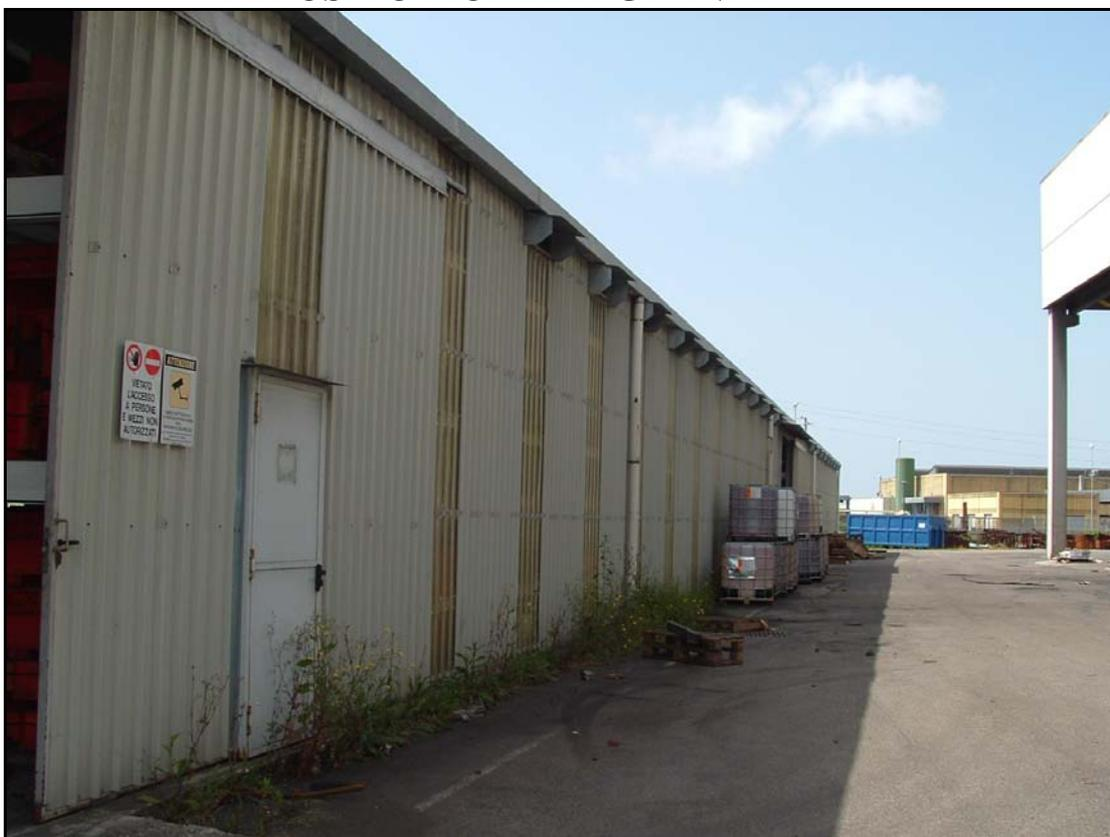
**FOTO N° 21: Deposito Modelli Capannone metallico misure ml 100x19 adibito a stoccaggio modelli clienti**
