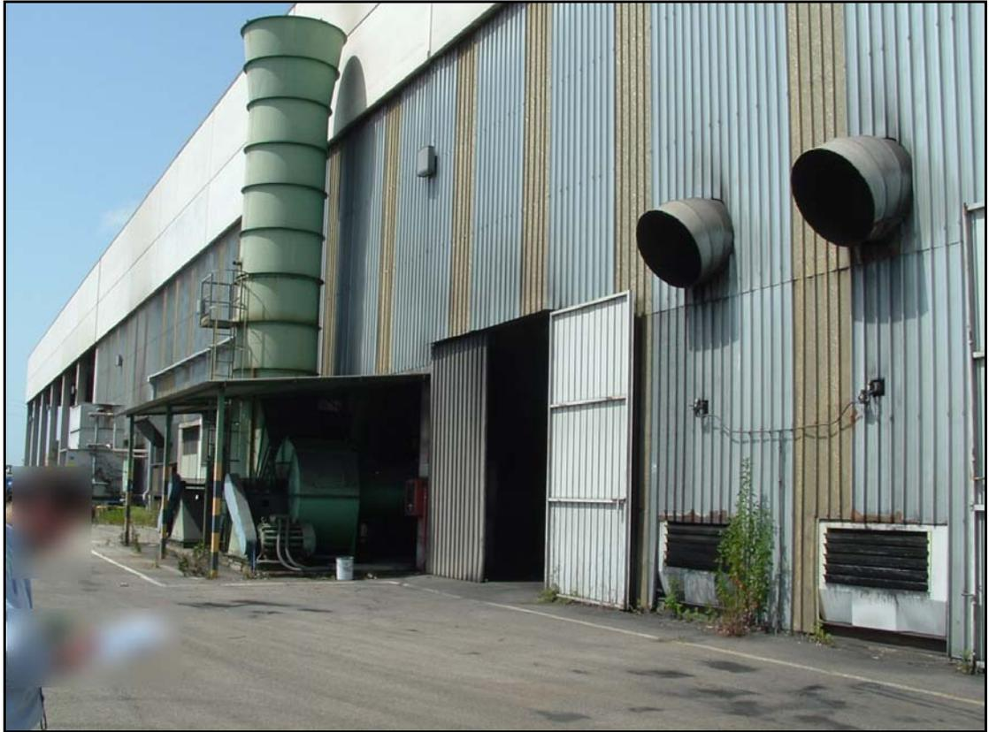
**FOTO N° 30:** L'impianto Torre di rigenerazione e relativi Silos Impainto Distaffatori sono allocati all'interno dell'ultima campata del capannone (pensilina). Quest'ultima al fine di contenere le polveri ed i rumori è stata schermata con pannelli in lamiera. L'elemento esterno alla pensilina è il filtro CTPI per polveri distaffatori.
