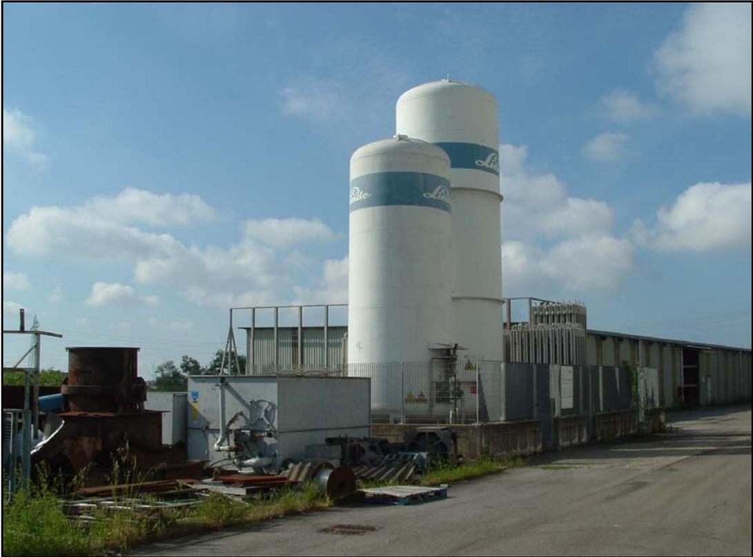
**FOTO N.º: 19 – Impianto Ossigeno in comodato d’uso non attivo- I serbatoi risultano vuoti e prossimi al ritiro da parte della società LINDE-**
