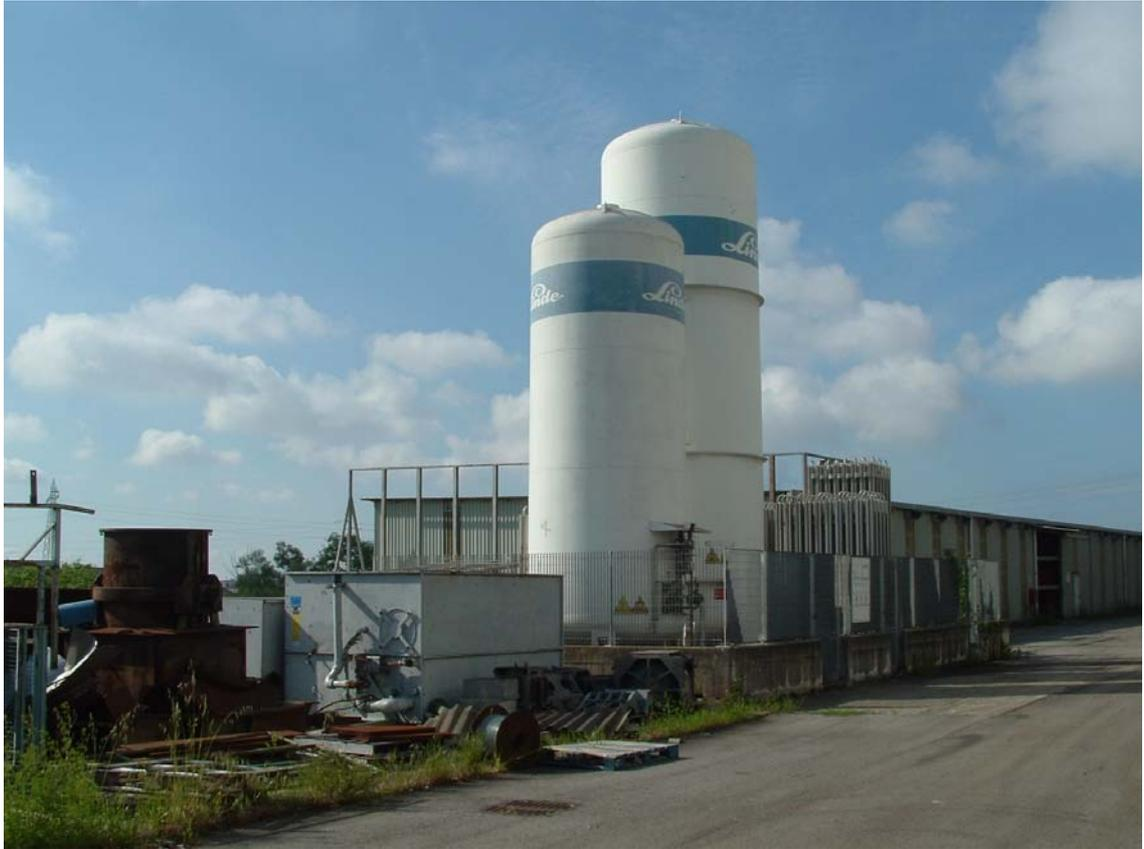
FOTO N° 28: Impianto Ossigeno n° 2 silos vuoti –impianto non funzionante in fase di smontaggio-
