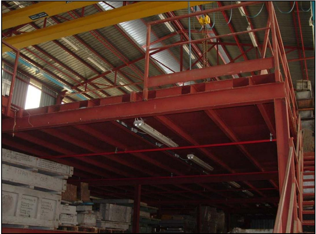
**FOTO N° 16: Interno Deposito Modelli-Tale Capannone a struttura metallica della complessiva altezza di ml 11 è dotato di ampio soppalco intermedio con struttura sempre in carpenetria metallica con altezza libera al di sotto del piano di calpestio pari a ml 3,60 (tale soppalco non è riportato sui grafici dei progetti approvati dal SUAP)**
