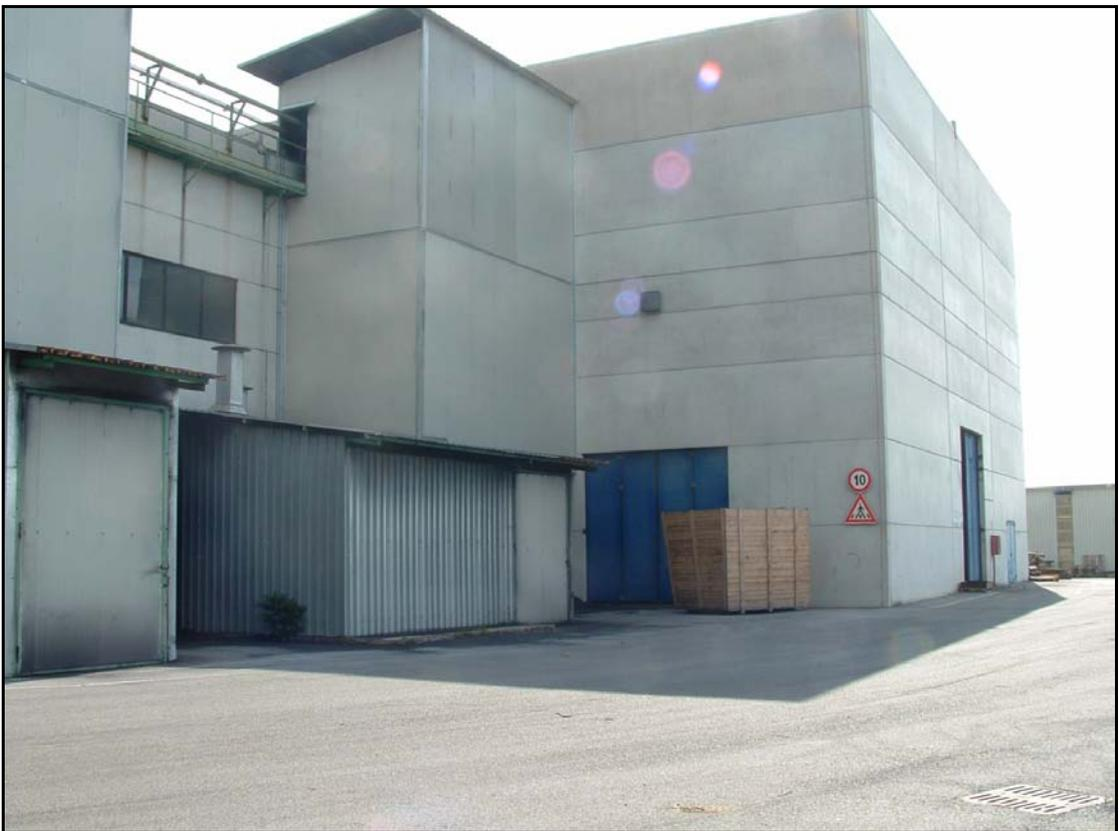
**FOTO N.º: 32-Retro Capannone parte esterna zona reparto mescolatori- Si rilevano silo per terre di recupero schermato con pannelli in lamiera**
