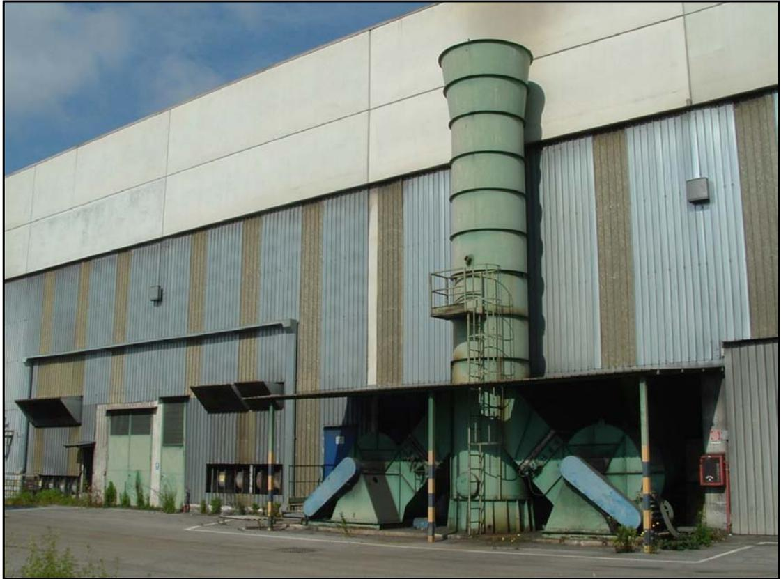
**FOTO N.º: 17 –Retro Capannone –La pensilina esistente è stata parzialmente schermata con pannelli metallici per insonorizzare e contenere polveri impianti esterni a servizio macchinari interni della line di produzione**
