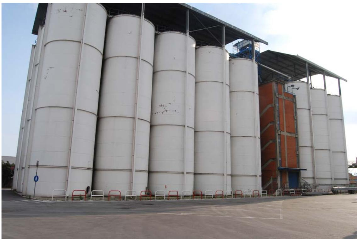
Sul lato sud del predetto corpo di fabbrica è presente un ulteriore corpo (tettoia metallica) posto a protezione della tramoggia. Per completezza si osserva che la tettoia presenta una tamponatura laterale in pannelli leggeri coibentati ed in parte in lastre trasparenti di polycarbonato.
