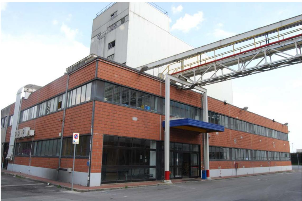
Per completezza giova far osservare che sul lato est e sud dell'edificio pastificio sono presenti alcune tettoie a struttura metallica, caratterizzate da una tamponatura laterale in pannelli leggeri coibentati ed in lastre trasparenti di policarbonato.
