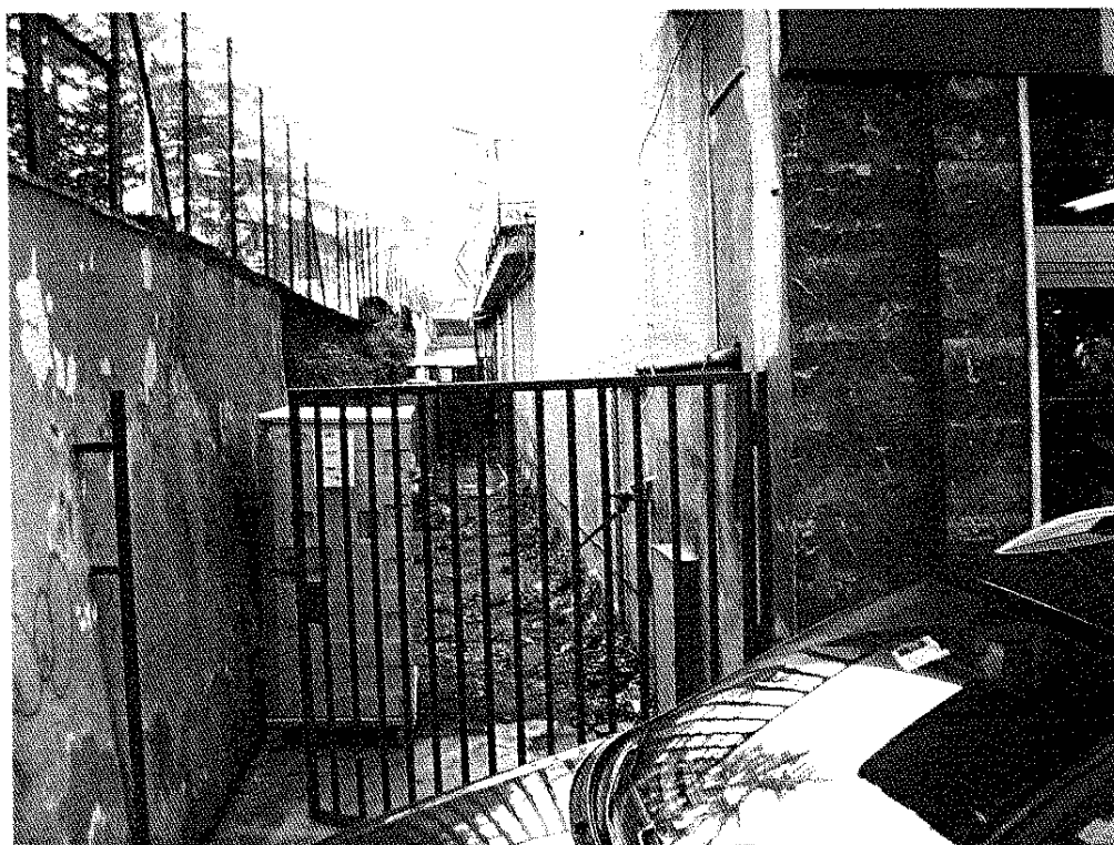
Foto n. 6 : Lato Est , area di pertinenza adibita al posizionamento delle macchine e a deposito di materiali legati all'esercizio dell'attività.
