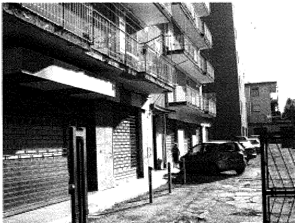
Foto n. 4 : Lato Ovest , l'area di sosta del "condominio Falcone" su cui affacciano le vetratte del supermercato.
