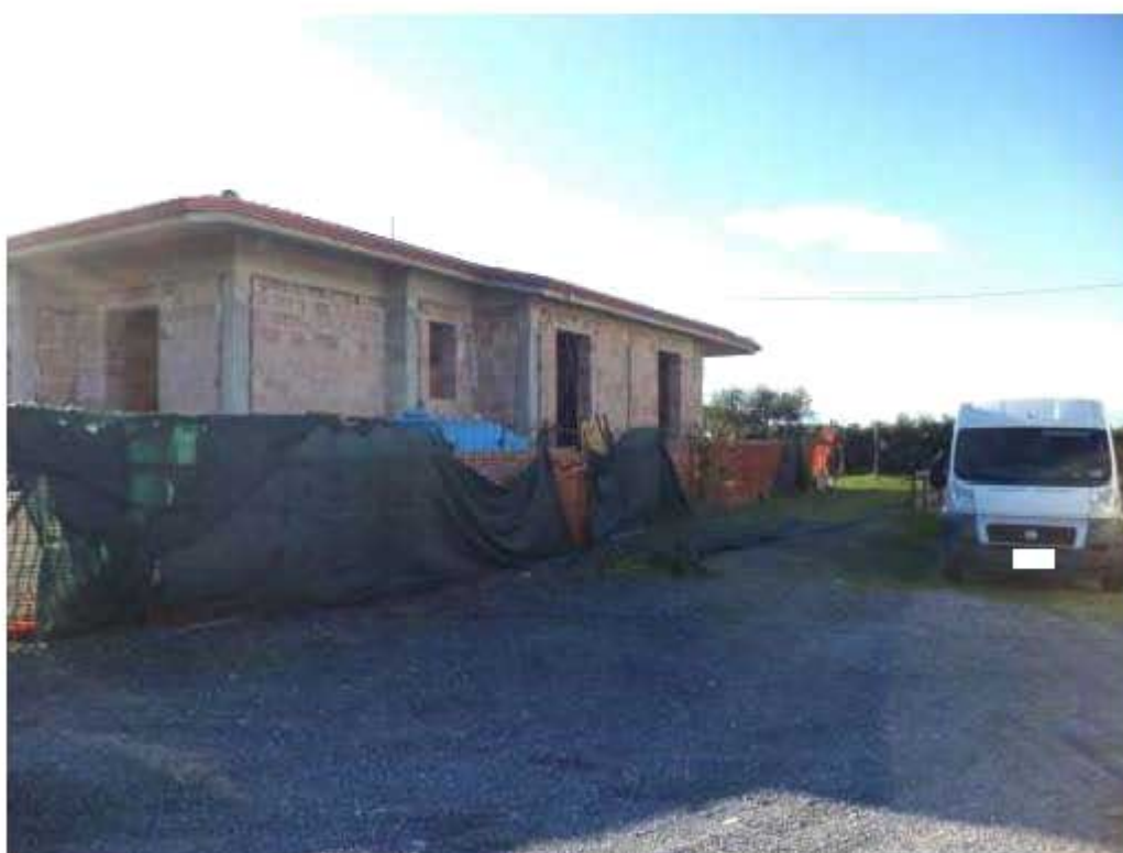
Foto 3 casa rurale realizzata solo nelle strutture portanti e tompagnature
