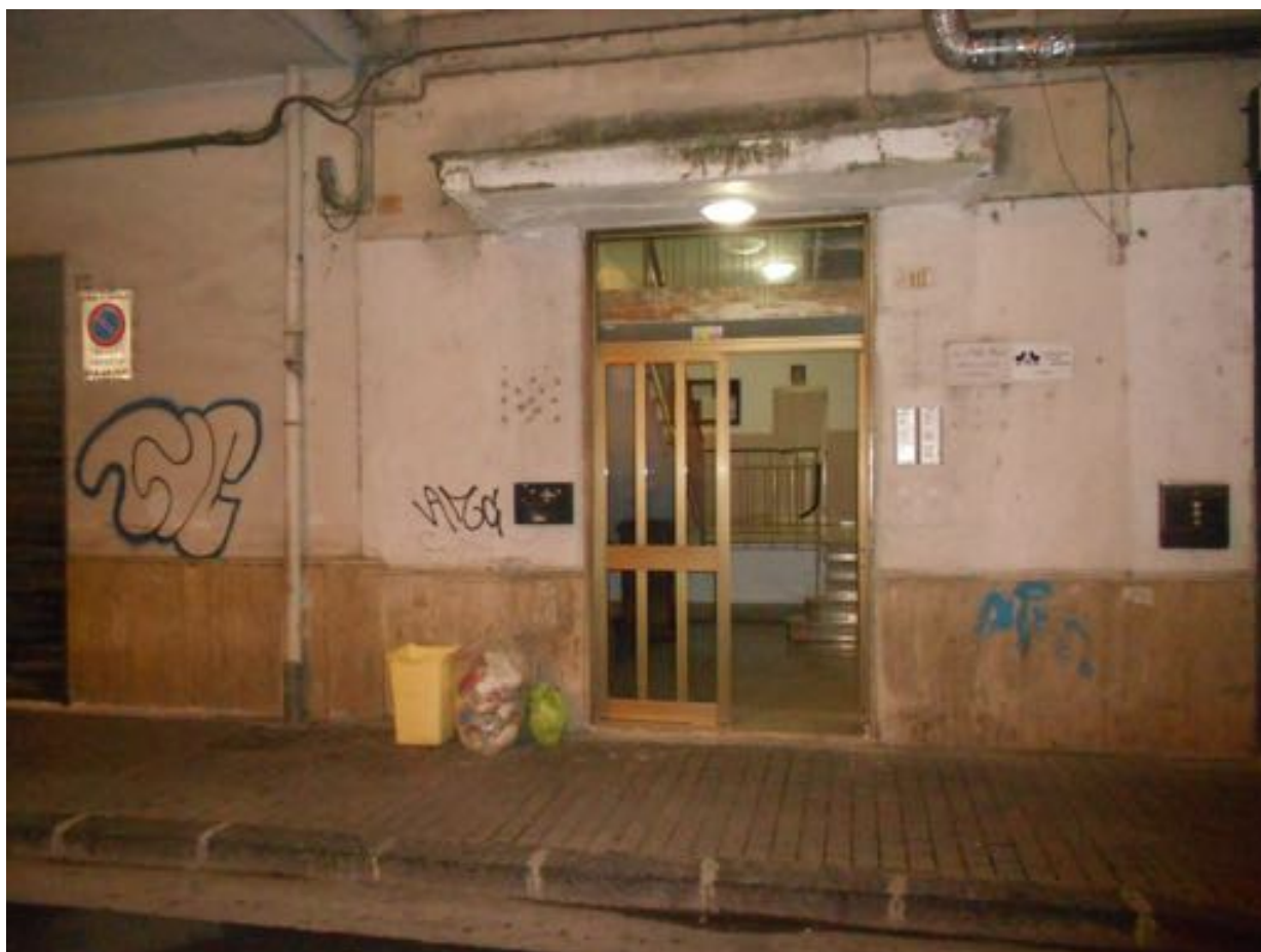
FOTO 2 – ESTERNO VIA PARINI, 10 PORTONE D'INGRESSO
