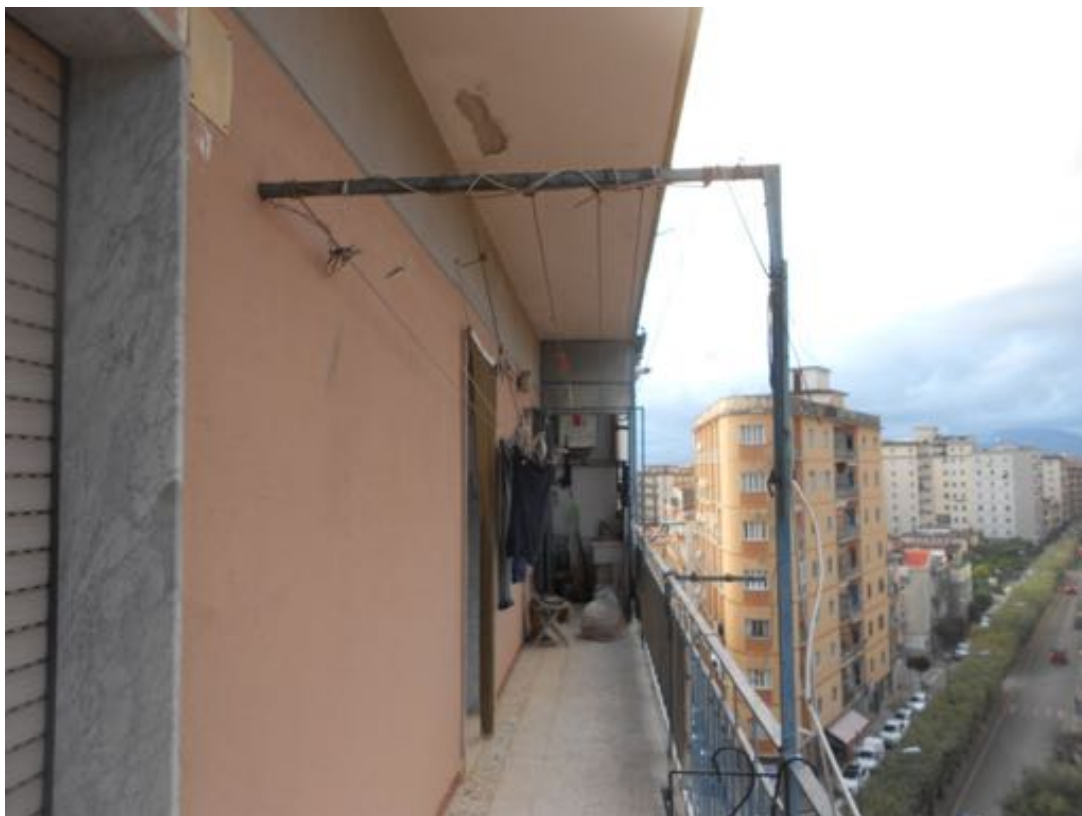
FOTO 5 – BALCONE LATO VIA PARINI
