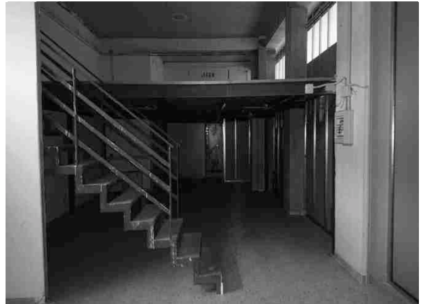
Foto 28 – vano 7 (deposito/soppalco) sub 57
