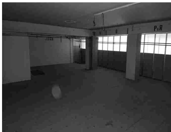
Foto 29 – vano 8 (deposito/soppalco) sub 57
