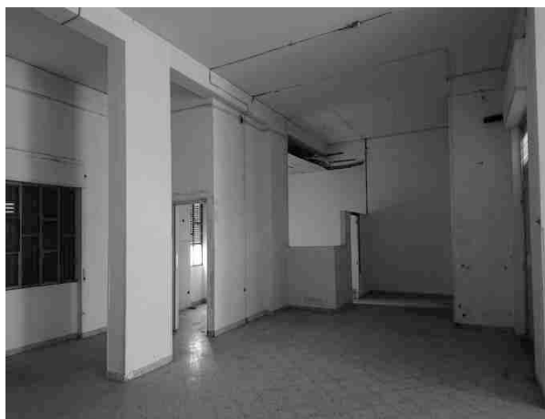
Foto 14 – vano 1 e vano 2 (laboratorio, attesa) sub 55
