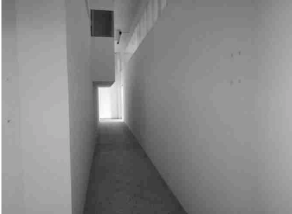
Foto 25 – vano 4 (corridoio) sub 57
